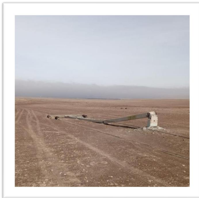
Ilustración 4: Poste derribado línea 66 kV Chapiquiña – Arica
